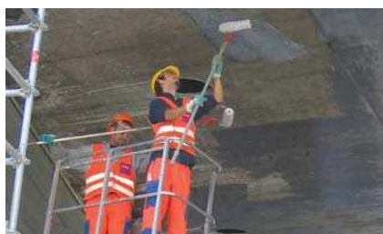
Правило 8, метод 8.1 Обработка гидрофобизатором Masterseal 303.
