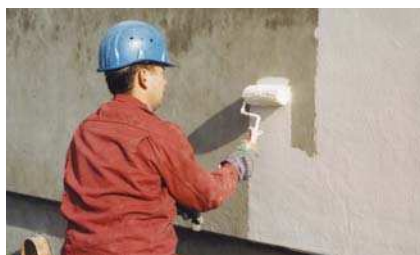
Правило 2, метод 2.2 Влажность или сырость в бетоне можно контролировать с помощью защитных покрытий Masterseal акрилатных, эпоксидных, полиуретановых, жестких, эластичных.
