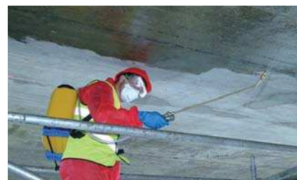
Правило 9, метод 9.1 Коррозия катодных областей армирования останавливается при применении материала Protectosil CIT.
