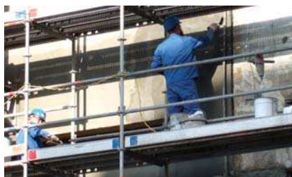
Правило 3, метод 3.1 Ремонтные смеси Emaco: Emaco Nanocrete R4 / R3 / R2 / FC Ручное нанесение.
