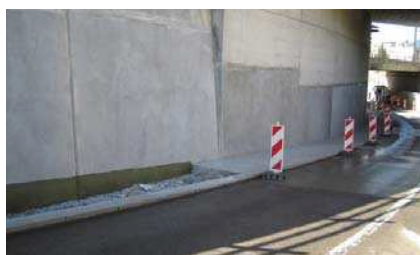
Правило 7, метод 7.2 Emaco Nanocrete R4/R3 Применяются для восстановления бетона, загрязненного хлоридами.
