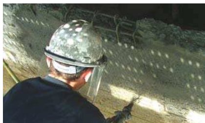
Правило 7, метод 7.1 Усиление армирования с помощью нанесения методом распыления Emaco Nanocrete R4.
