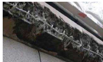
Правило 11, Метод 11.1 Активная антикоррозионная защита с помощью Emaco Nanocrete AP.
