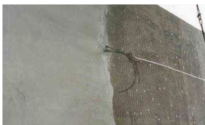
Правило 10, метод 10.1 Активированные титановые аноды входят в состав Emaco CP10, специально разработанный для оптимальной совместимости с анодом катодной защиты.
