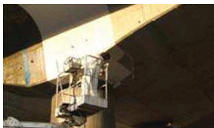
Правило 1, метод 1.2 Защитные покрытия Masterseal: например, жесткий или эластичный акрилат, эпоксидные или полиуретановые материалы, защищающие от всех видов воздействий.
