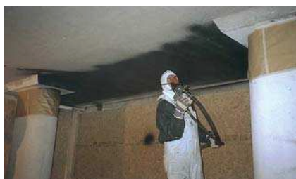
Правило 10, метод 10.1 Проводящее покрытие Emaco CP 30 обеспечивает катодную защиту железобетона без существенного увеличения массы конструкции.
