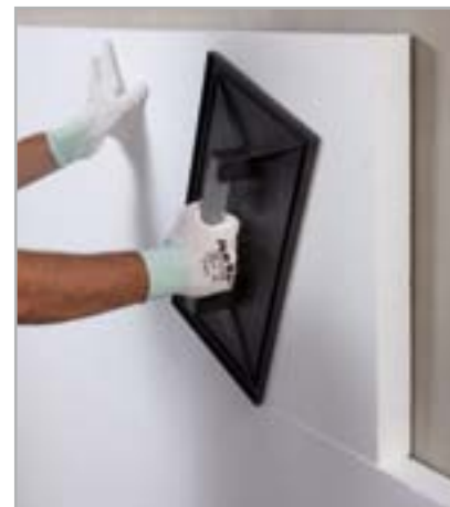
Рис. 5.11 – Придавите панель гладилкой
