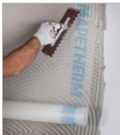
Рис. 5.16 – Поместите на поверхность MAPETHERM NET
