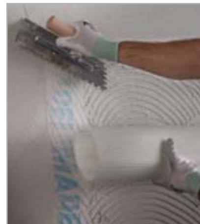
Рис. 5.17 – Перекройте края сетки, как минимум, на 10 см
