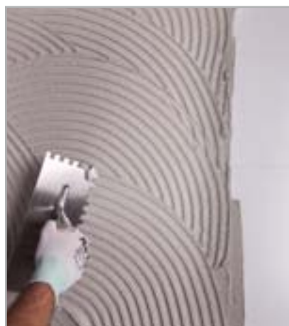
Рис. 5.15 – Нанесите первый слой выравнивающего и разглаживающего раствора
