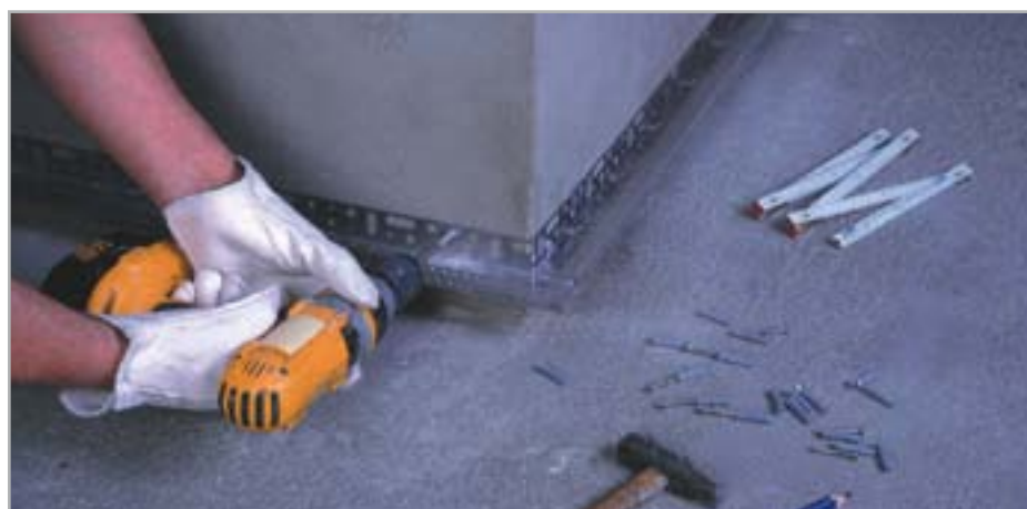
Рис. 5.7 – Крепление поддерживающих профилей на месте, посредством дюбелей
