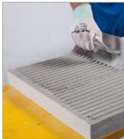
Рис. 5.8 – Нанесите равномерный слой клея на тыльную сторону изоляционной панели
