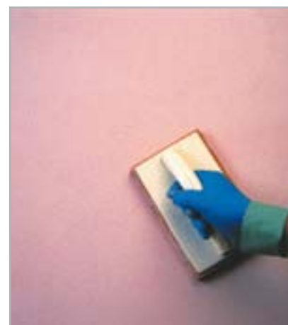
Рис. 5.19 – Разгладьте поверхность штукатурки губчатой гладилкой SPONGE FLOAT
