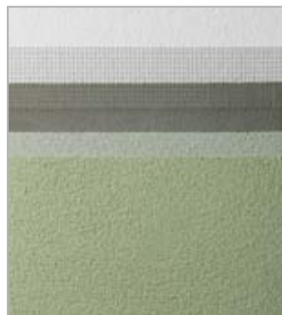
Рис. 2.3 – MAPETHERM со вспененным пенополистиролом
