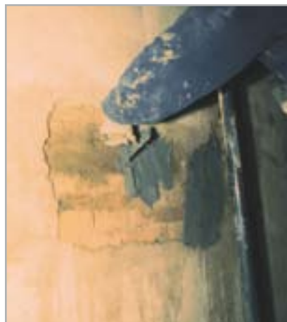
Рис. 5.5 – Ремонт отслоившейся штукатурки с помощью NIVOPLAN+PLANICRETE
