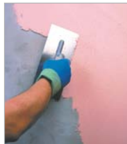
Рис. 5.18 – Нанесите слой отделочной штукатурки
